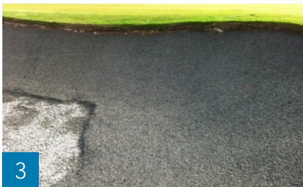
Capillary Concrete in einer gleichmäßigen Schichtdicke von 5 cm aufbringen
